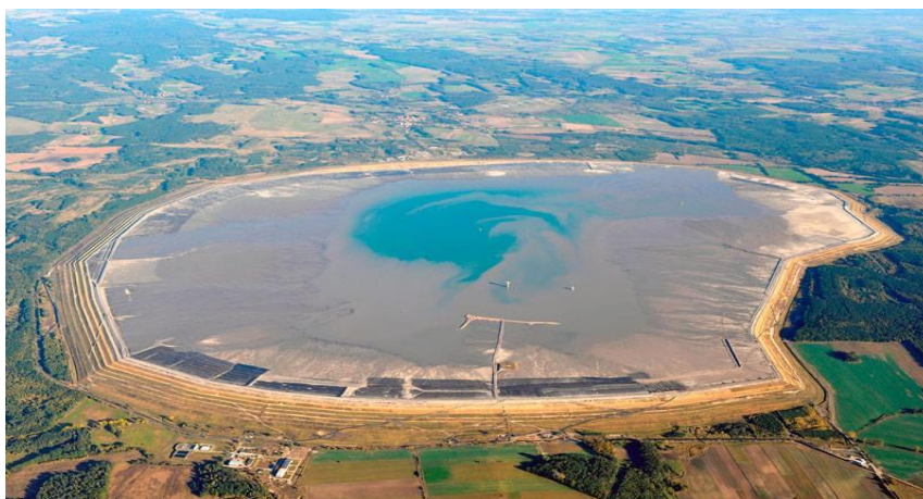
Rysunek 4 Ogólny widok – obiektu unieszkodliwiania odpadów „Żelazny Most” [223]
